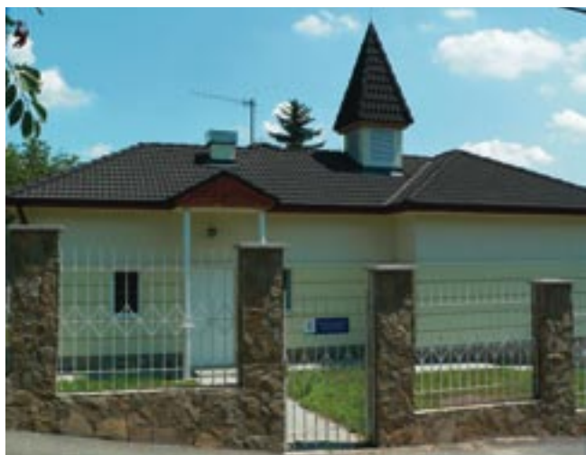
A Bükkfia utcai gépház rekonstrukció után After reconstruction of the Bükkfia street pump house
