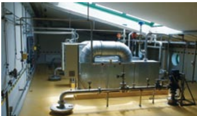
A Csepeli Vízkezelőmű ózonos tisztító rendszere Ozon purification system of the Csepel Water Treatment Plant
