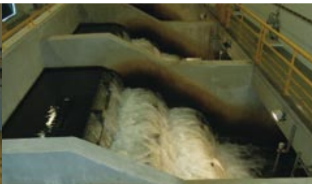
Vízisztítás első lépcsője a Csepeli Vízkezelőműben First stage of water purification in the Csepel Water Treatment Plant
