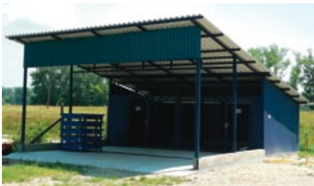
Az Északi Védőterületi csoport olajtárolója a felújítás után Oil container of Northern Protected Area Group, after renovation
