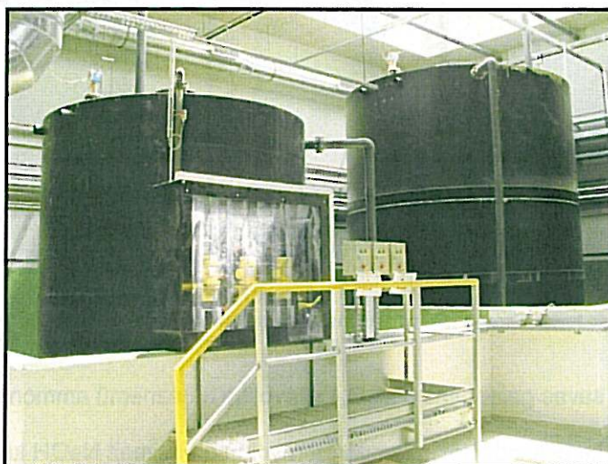
2. ábra: Baloldalon: 2 m 3 H 2 SO 4 tároló tartály; jobbra: 25 m 3 NaOH tároló tartály és 65 m 3 NaOCl tároló tartály.
